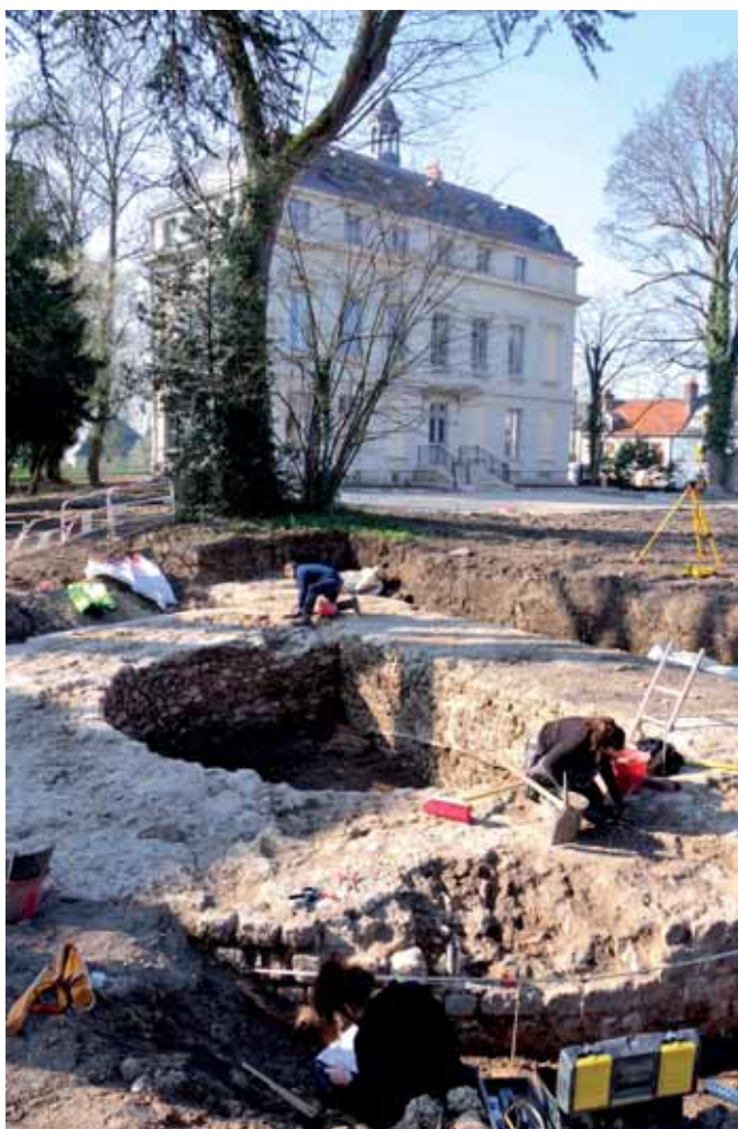
8. Dégagement en cours des fondations de la Tour de l'Étoile.
